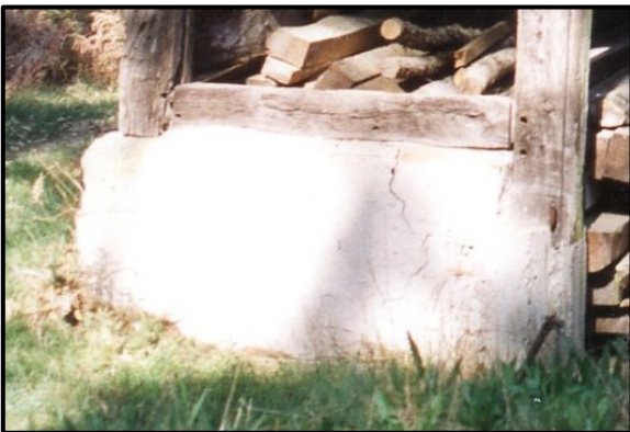
Enduit au lait de chaux
