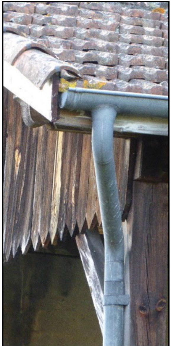
Gouttière et descente en zinc naturel
