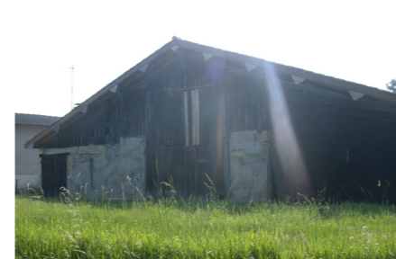
4- Dépendance Branat façade Est
