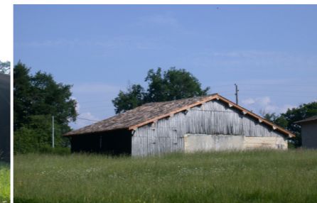
4- Dépendance Branat façade Ouest
