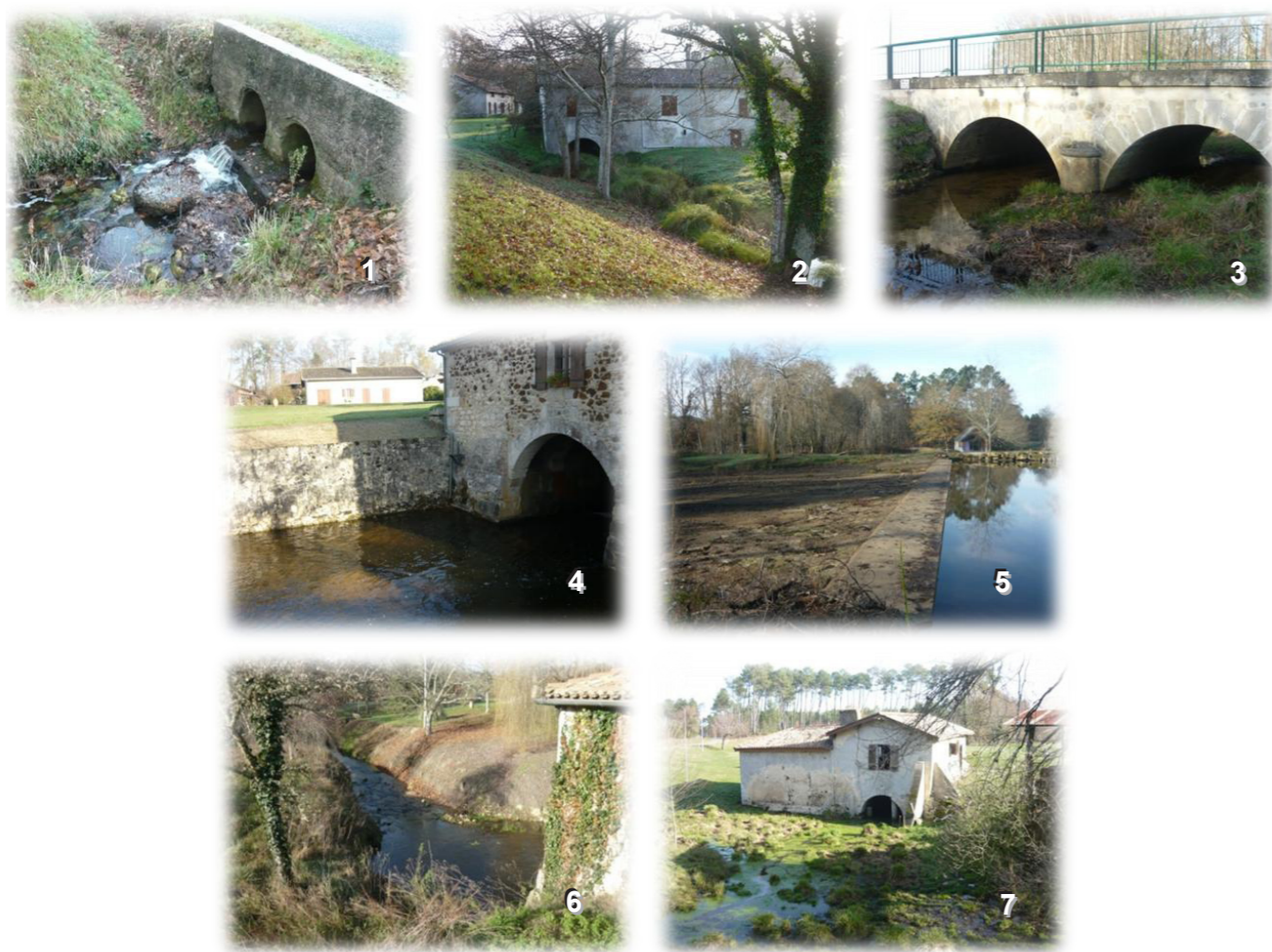
Illustrations des principaux ouvrages hydrauliques de ce bief (dans l'ordre) : buse Ba1 (1), moulin de Bon Loc (2), ouvrage de la RD 10 (3), moulin des Monges, déversoir et vue aval (4 à 6) et moulin de Muset (7)
