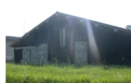
4- Dépendance Branat façade Est
