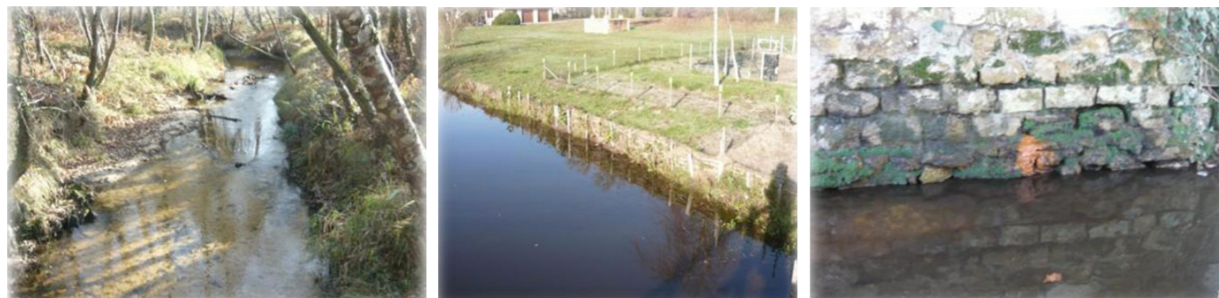
Berges naturellement stabilisées par la ripisylve ou artificiellement confortées au niveau de la retenue
