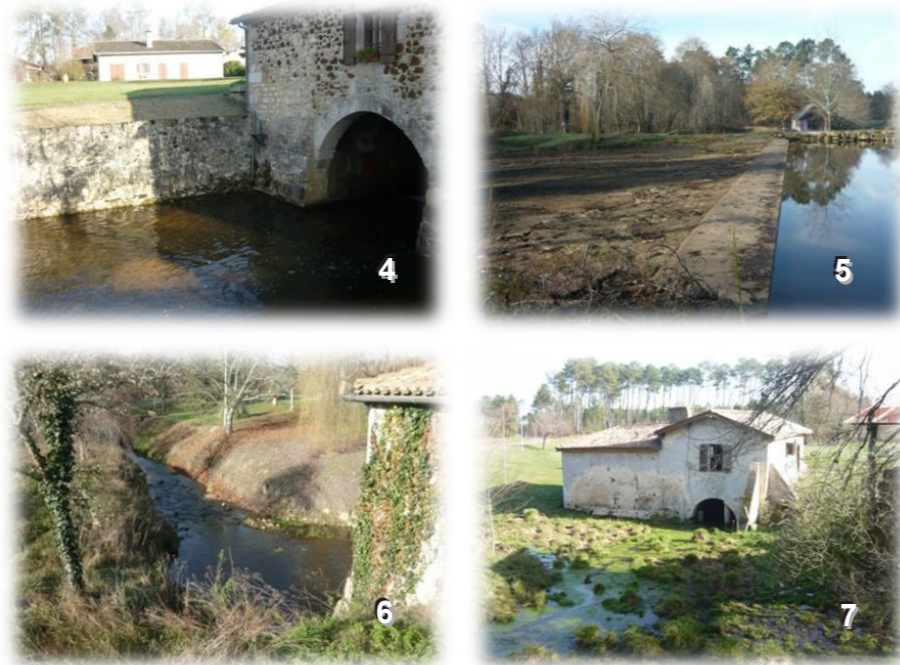
Illustrations des principaux ouvrages hydrauliques de ce bief (dans l'ordre) : buse Ba1 (1), moulin de Bon Loc (2), ouvrage de la RD 10 (3), moulin des Monges, déversoir et vue aval (4 à 6) et moulin de Musset (7)
